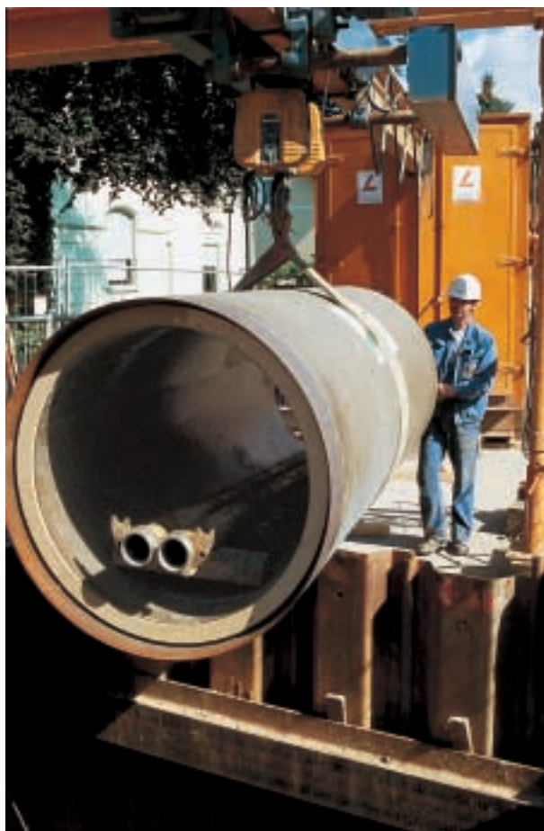
4 Tubo de betão de polímeros DN 1000 adequado à cravação
