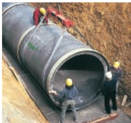
2 Instalação da tubagem DN 2000 em obra
