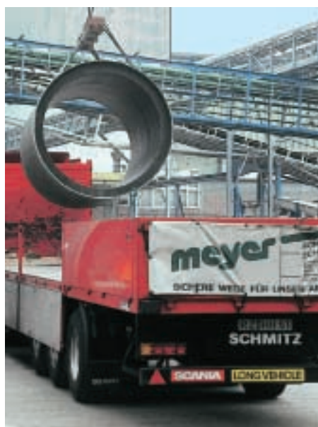
1 Tubo em betão de polímeros DN 2000 à saída da fábrica
