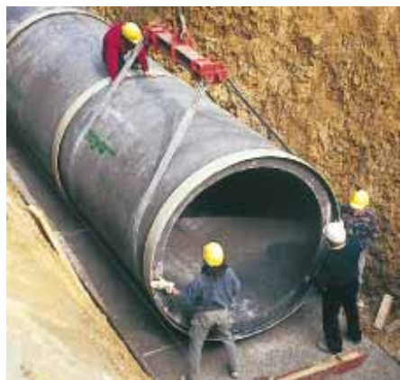
2 Verlegung von Kanalrohren aus Polymerbeton
