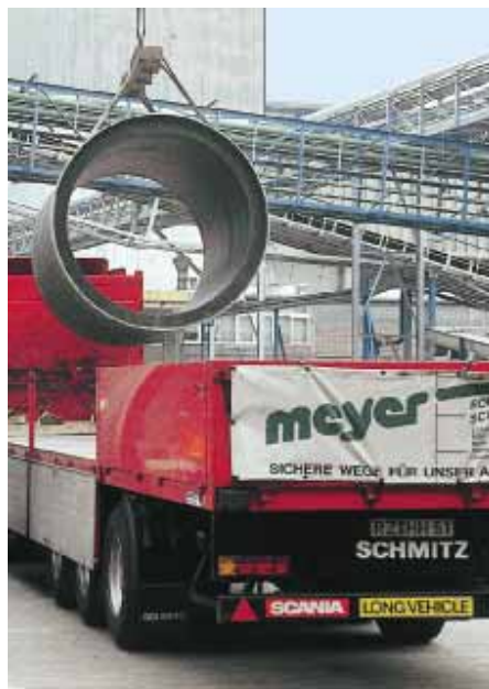
1 Kanalbaustelle mit Rohren DN 2000 aus Polymerbeton in einem Industriebetrieb
