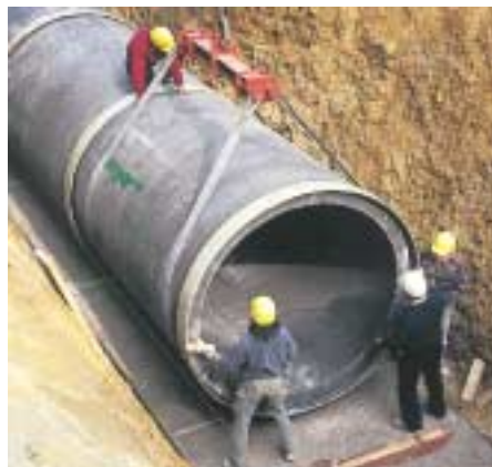
2 Colocación de tubos de hormigón polímero DN 2000 para saneamiento
