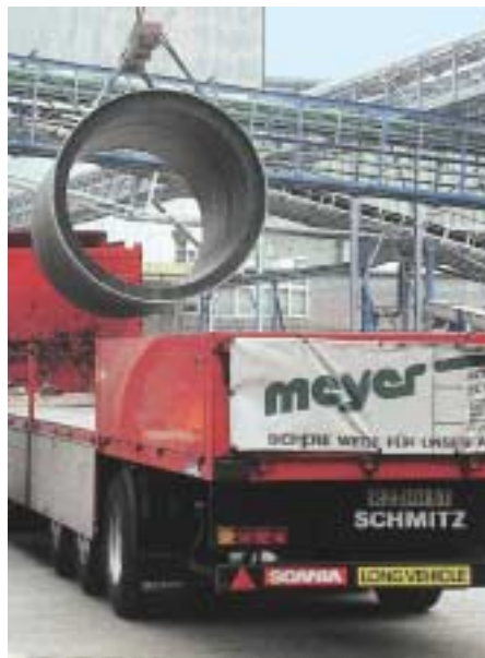
1 Tubos de hormigón polímero DN 2000 para saneamiento en una planta industrial
