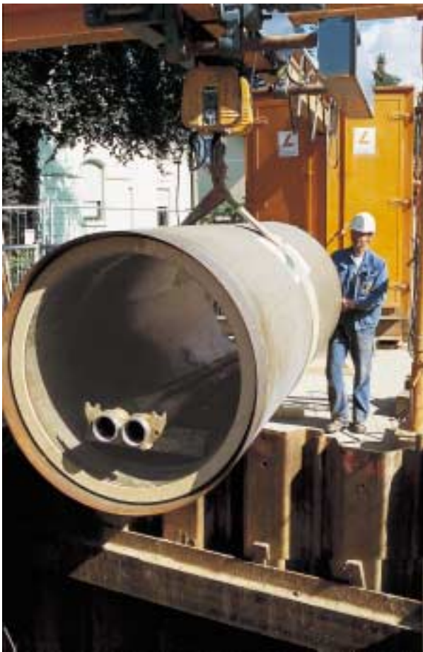
4 Tubo de hinca de hormigón polímero DN 1000 con manguito de acero
